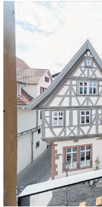
Sieben Jahre stand das Gebäude in der historischen Altstadt leer.
